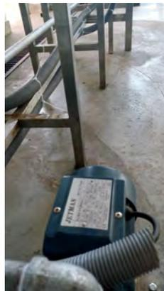
**Figura 3.107. Tubo corrugado en el cable de alimentación de la bomba**
