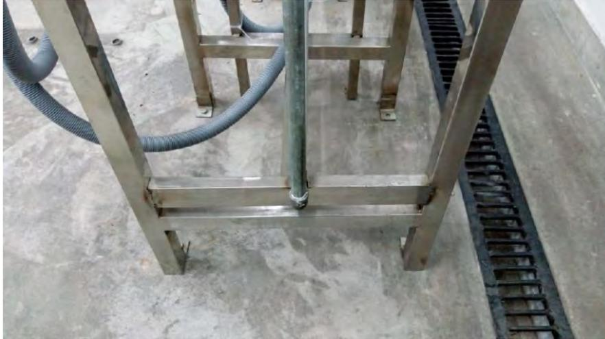
**Figura 3.63. Barra transversal de soporte de la tubería**
