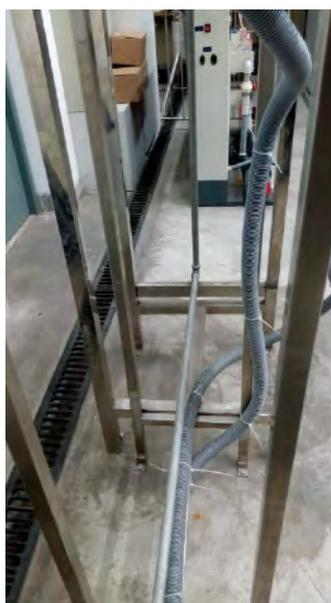
**Figura 3.62. Tubo transversal situado por debajo de los tanques**
