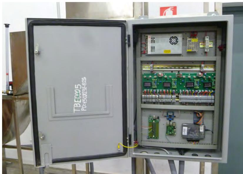
**Figura 3.112. Cableado interno del panel de control**
