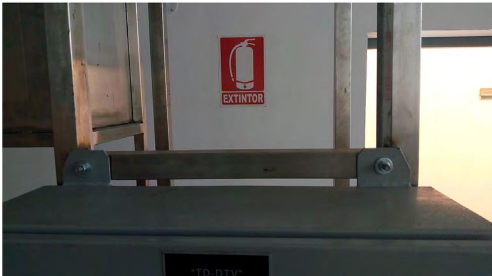
**Figura 3.65. Orejas de sujeción del panel de control**
