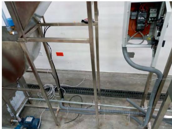
**Figura 3.105. Protección de cables con tubos corrugados**
